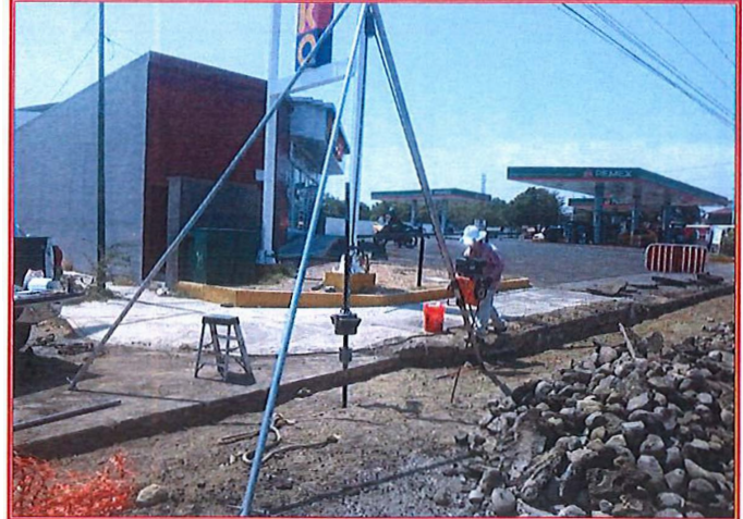
Fotografías 1 y 2 : Realización de los sondeos exploratorios SPT.
